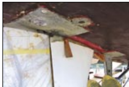
5: Z zagozdami zavarovan stabilizator krmila med postopkom strjevanja oziroma sušenja smole
