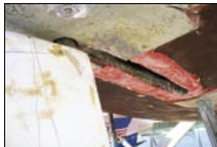
4: Pred montažo je potrebno os. material na mestu vgradnje obrusiti tako, da so vidne nitke tkanine (mate).
