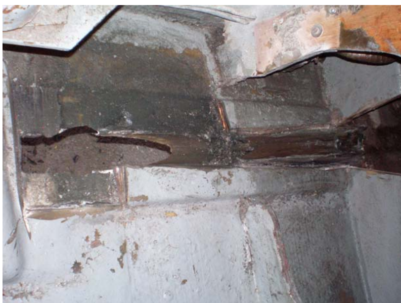
Slika 2: Demontaža statvene cevi s primernim orodjem
